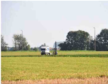
Les travaux de Tournai Ouest III devraient débuter en mars © B.L.
